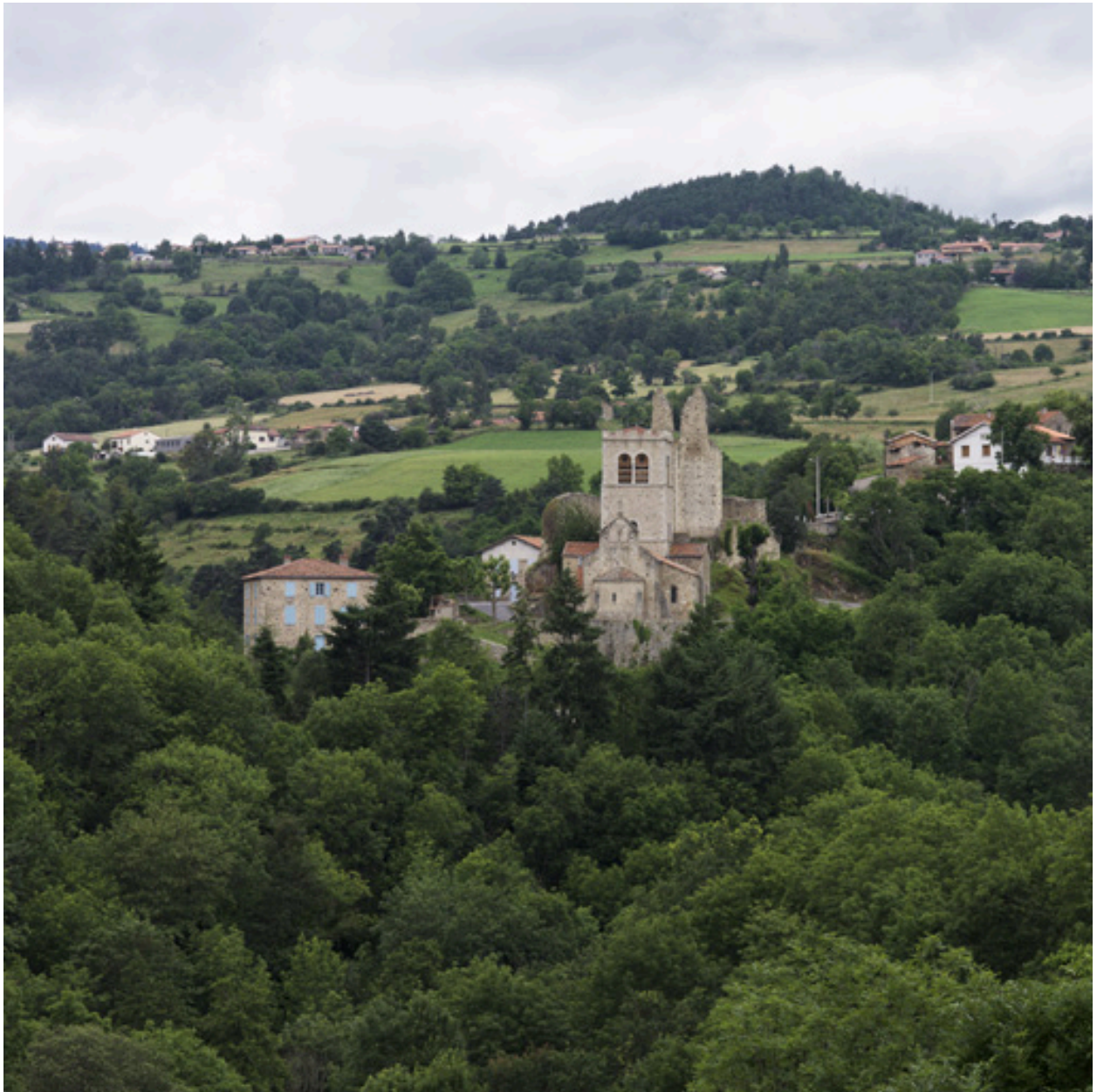
Vue générale depuis l'est.
