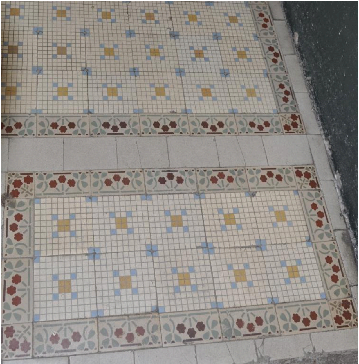
Immeuble sur rue, détail du pavement de l'allée
