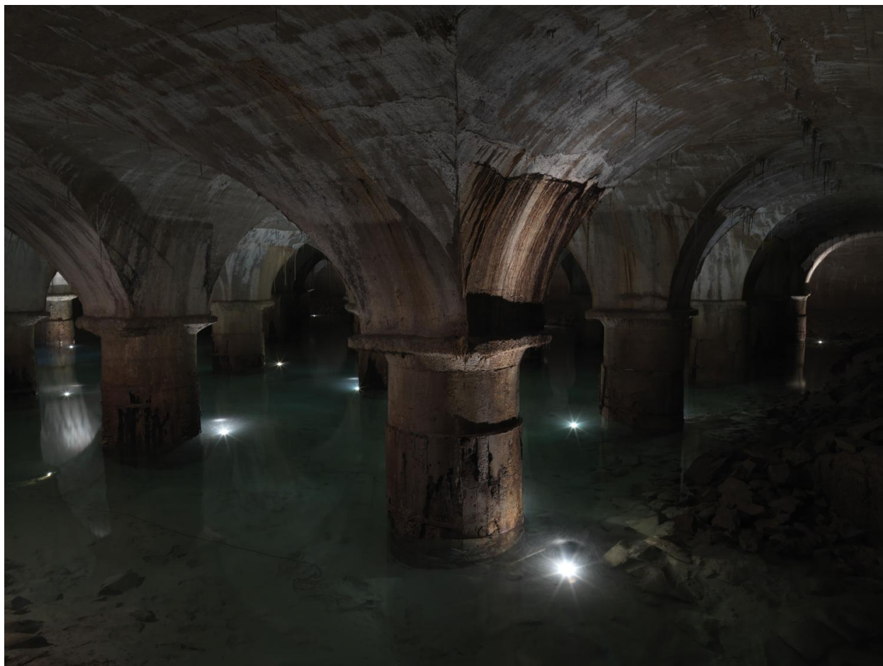
Vue des bassins filtrants
