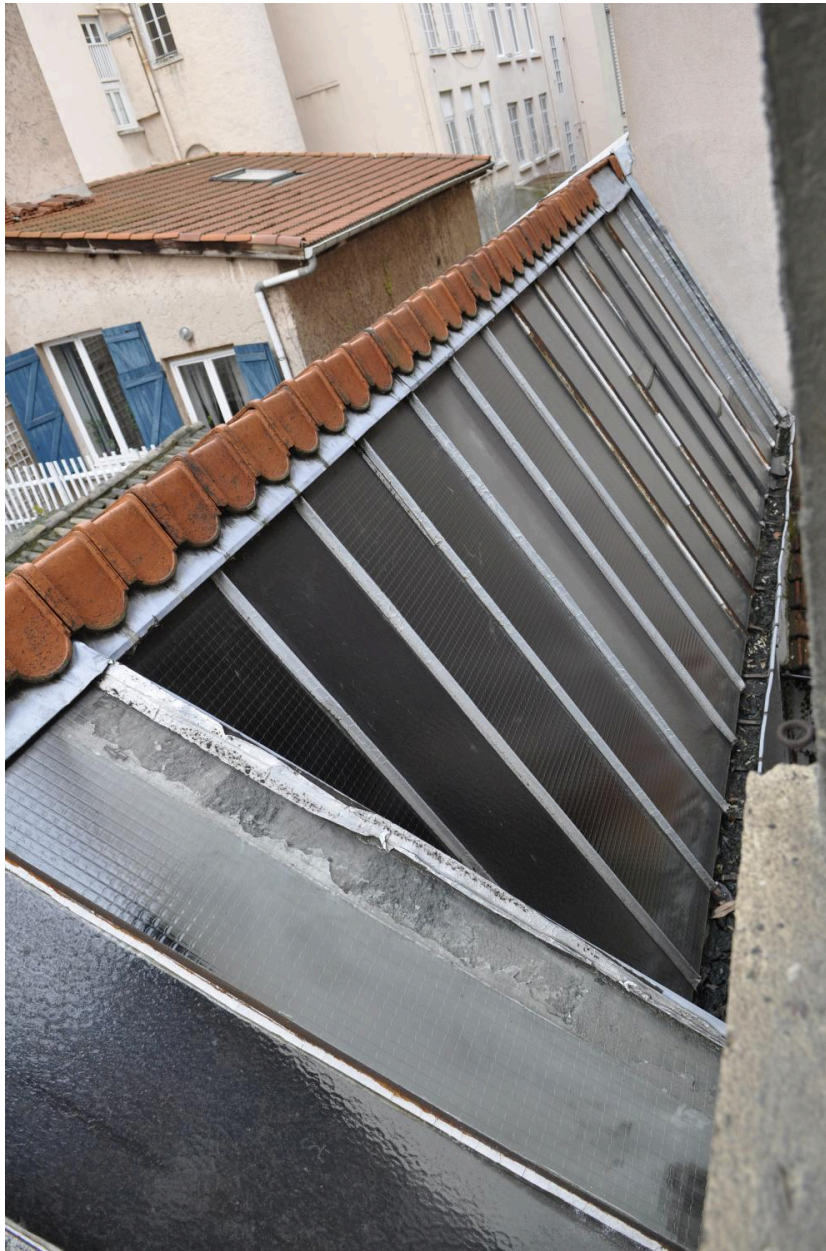
Vue des toitures de l'atelier de tissage mécanique Mattelon en rez-de-chaussée
