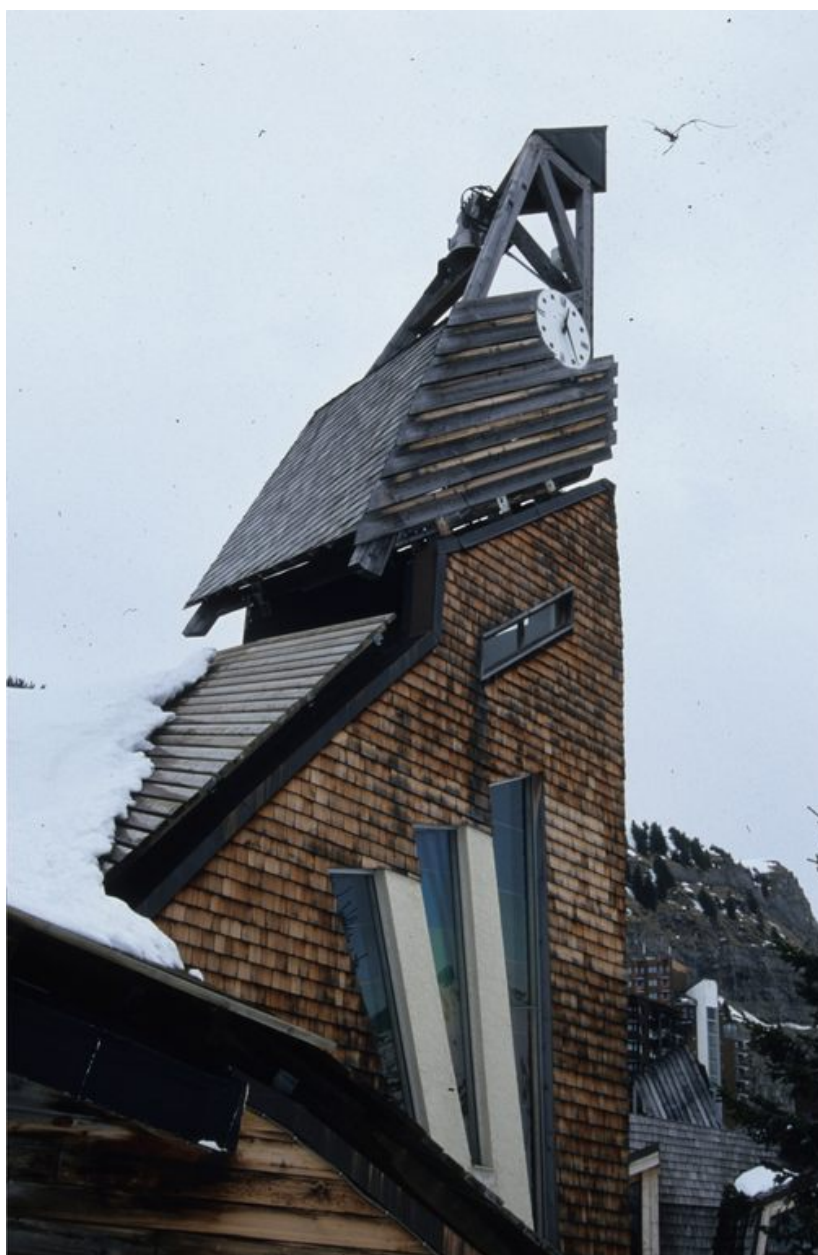
Détail du beffroi, depuis le sud-ouest
