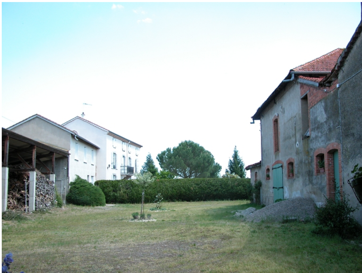
Vue du bâtiment nord, depuis le sud-ouest.
