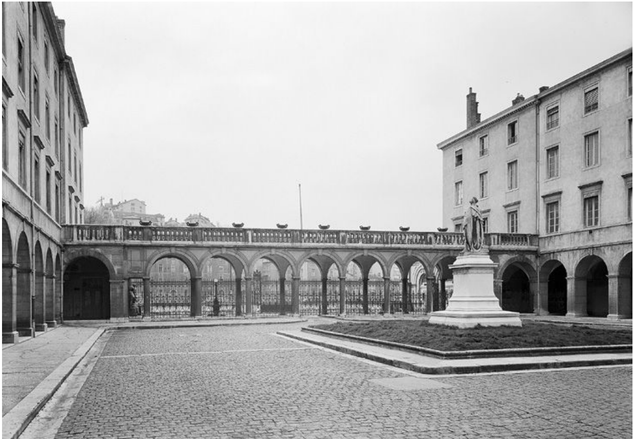
Corps de portique, côté cour
