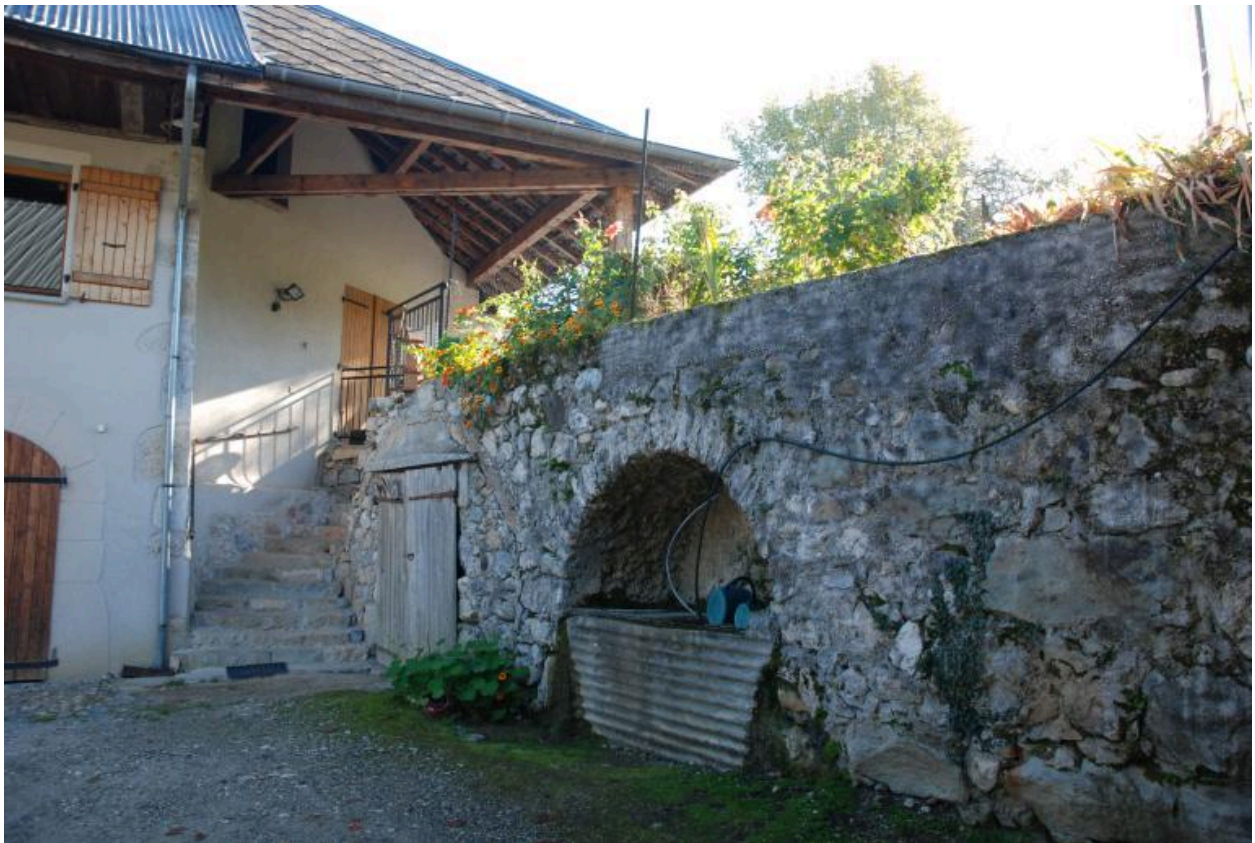
Vue d'ensemble du mur de soutènement avec porte de cave et bassin sous niche.
