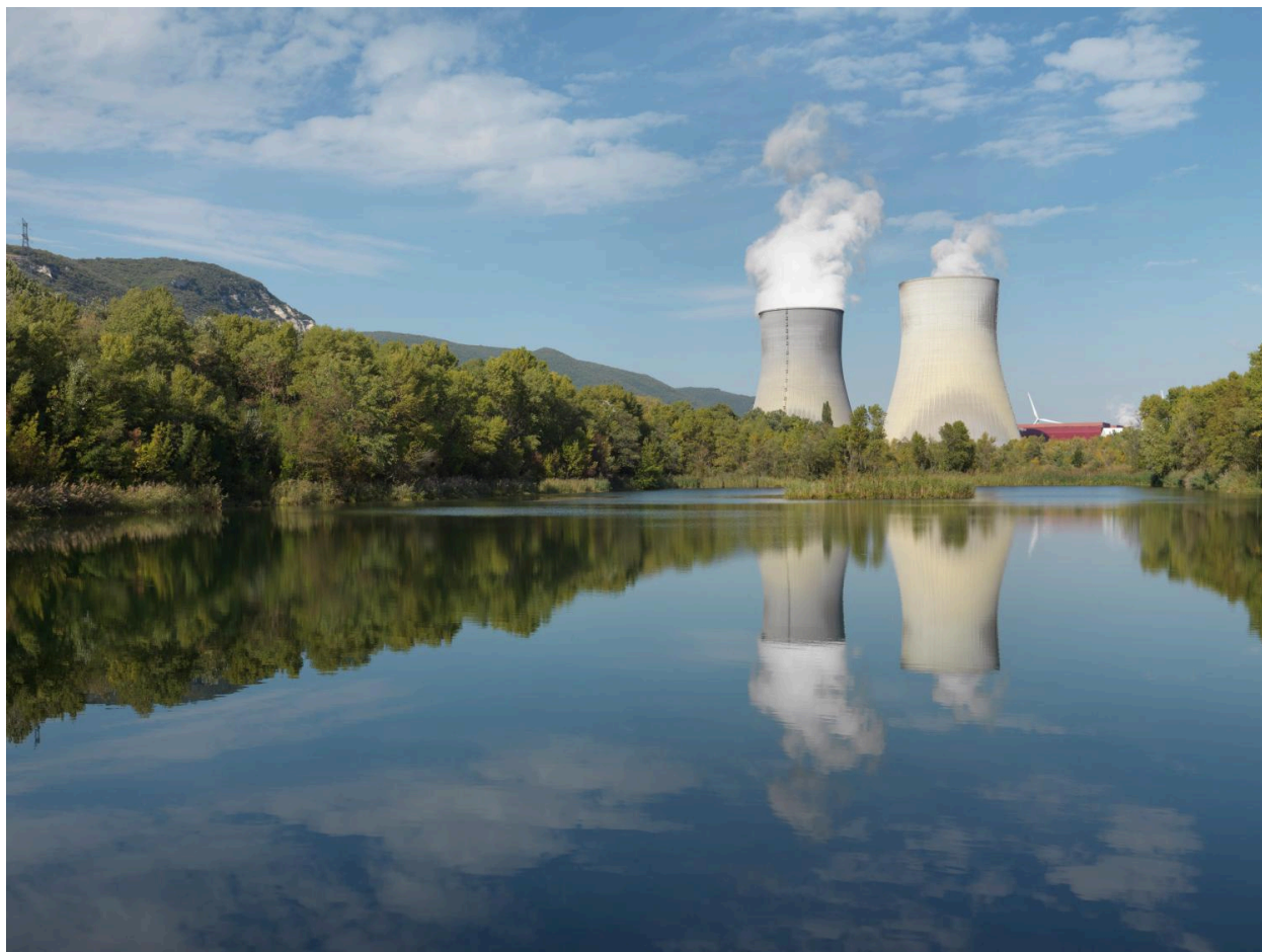
Tours de refroidissement
