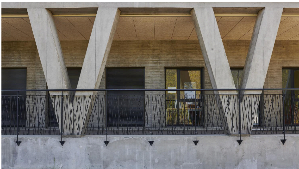
Détail des structures portantes
