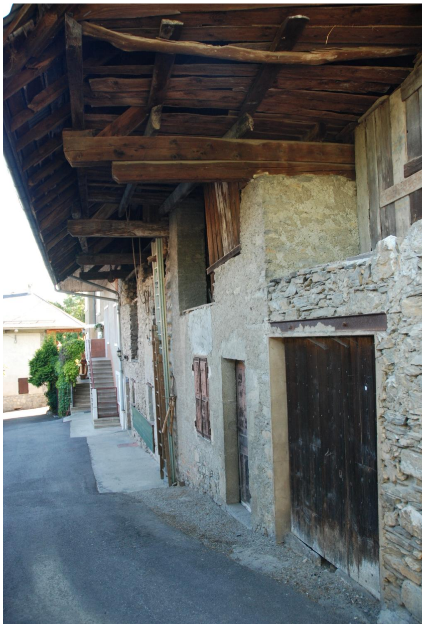
Fermes à juxtaposition (2018 I1 51 à 55), vue d'ensemble depuis le nord.
