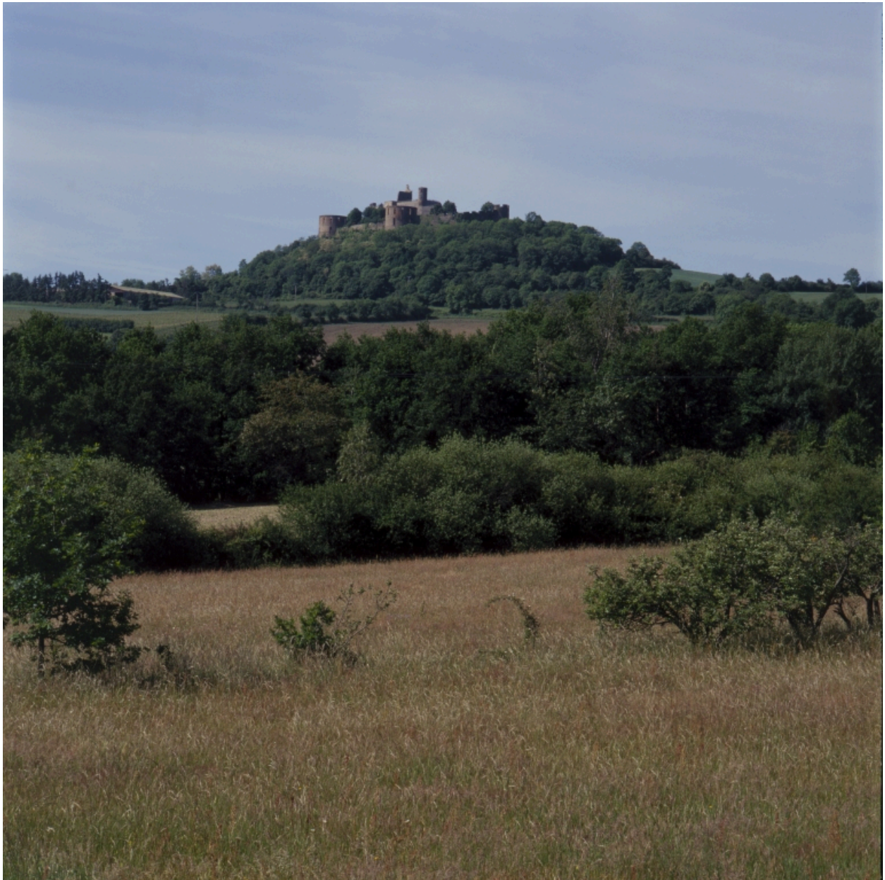
Vue générale du site, du nord-est.
