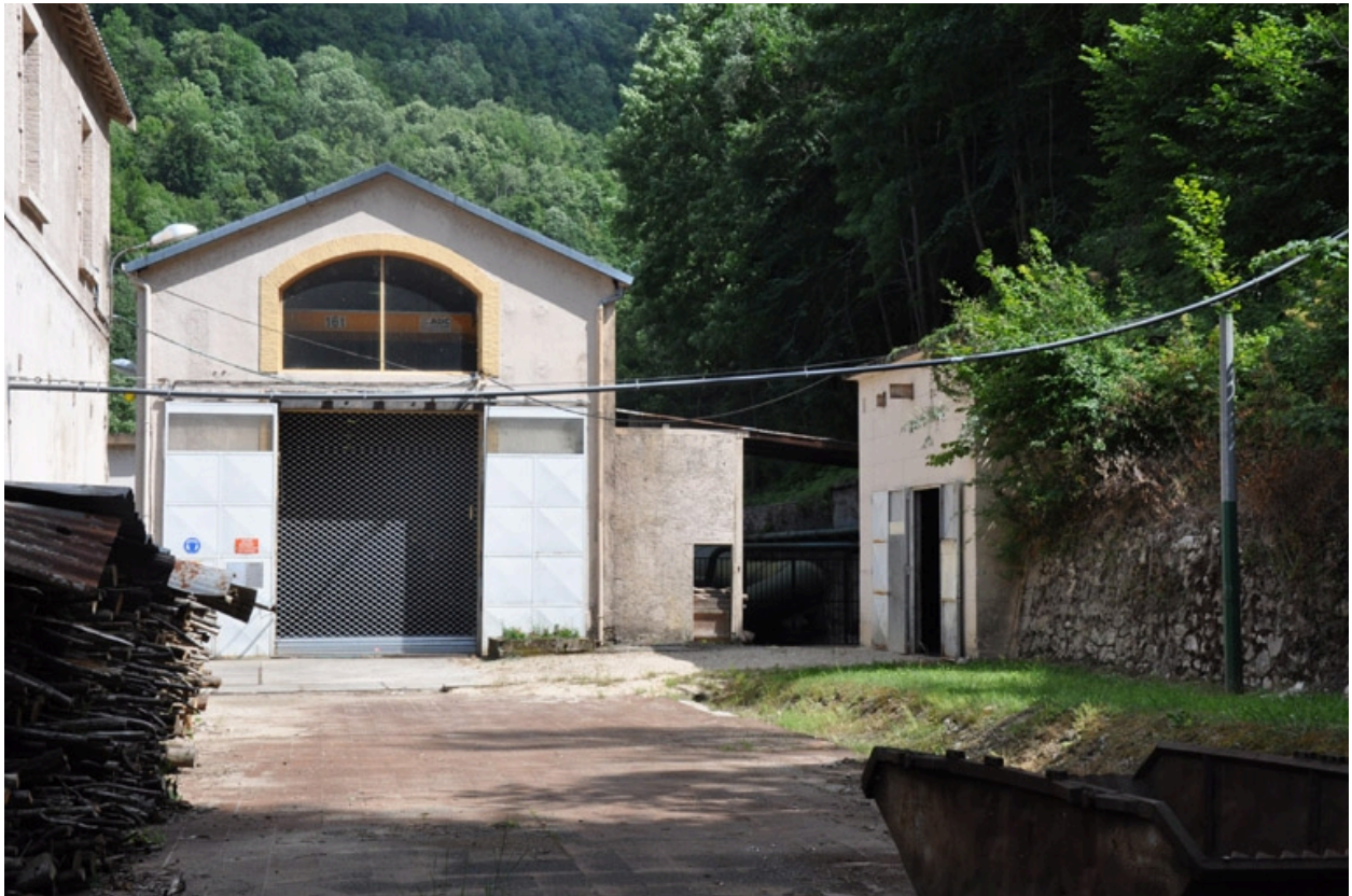
Vue de la centrale hydroélectrique de Saint-Béron sur la commune de Voissant, département de l'Isère
