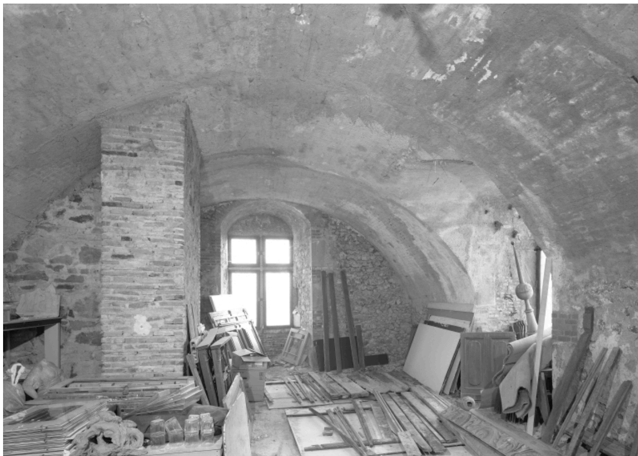
Bastion sud-est, rez-de-chaussée surélevé : vue générale de la pièce, de l'ouest.
