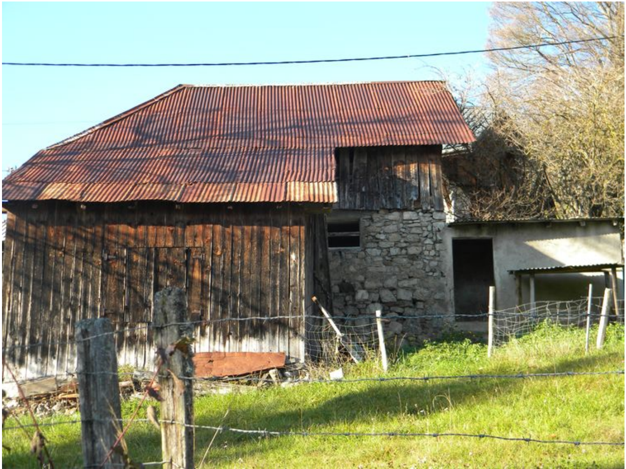
Vue de la façade sud.
