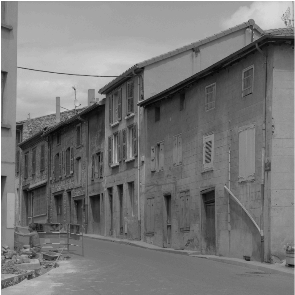
Vue de la rue de Roanne au départ de la place Rolle, du sud-ouest.
