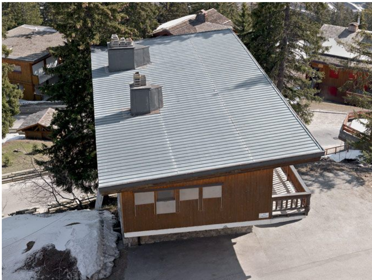
Vue d'ensemble de la toiture
