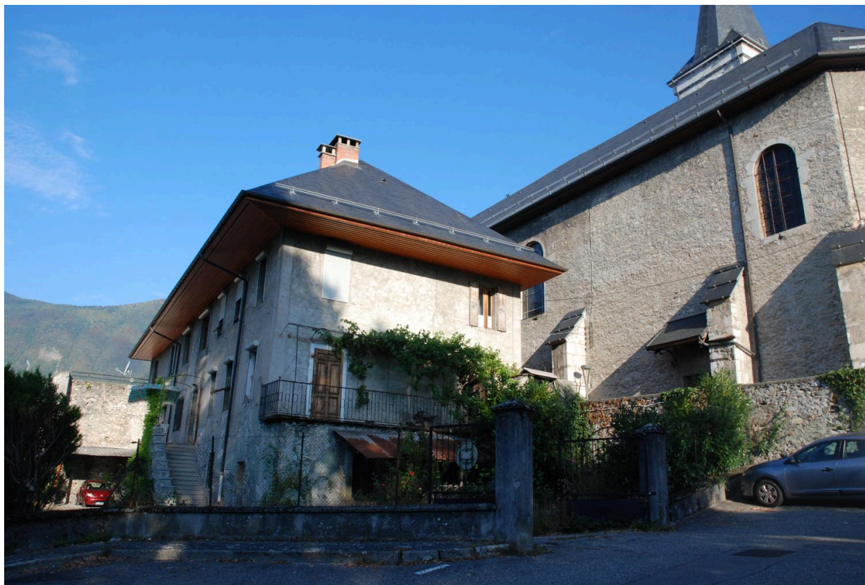
Vue d'ensemble depuis l'est.
