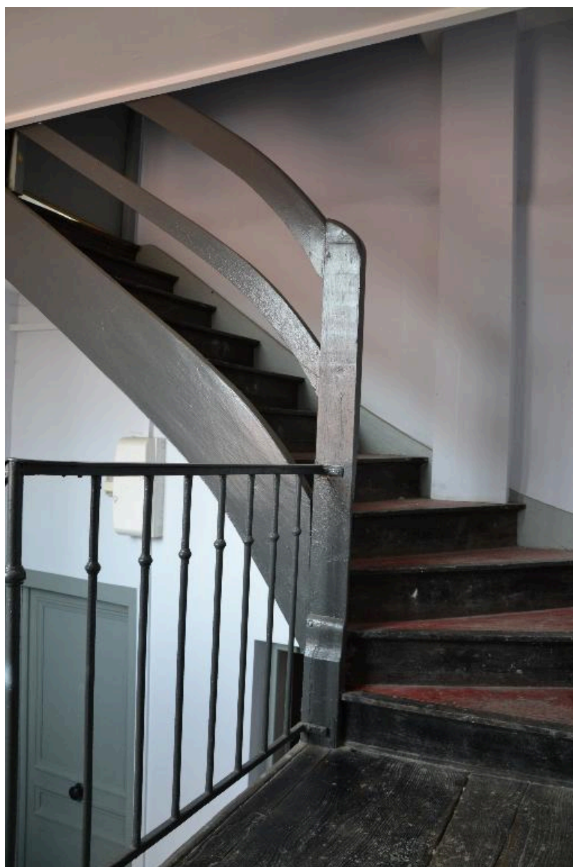
Escalier dernier niveau
