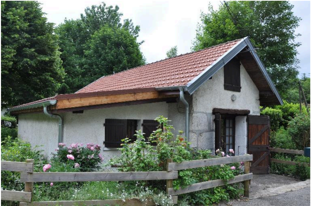
Vue de trois-quart de l'ancien four depuis le nord-ouest
