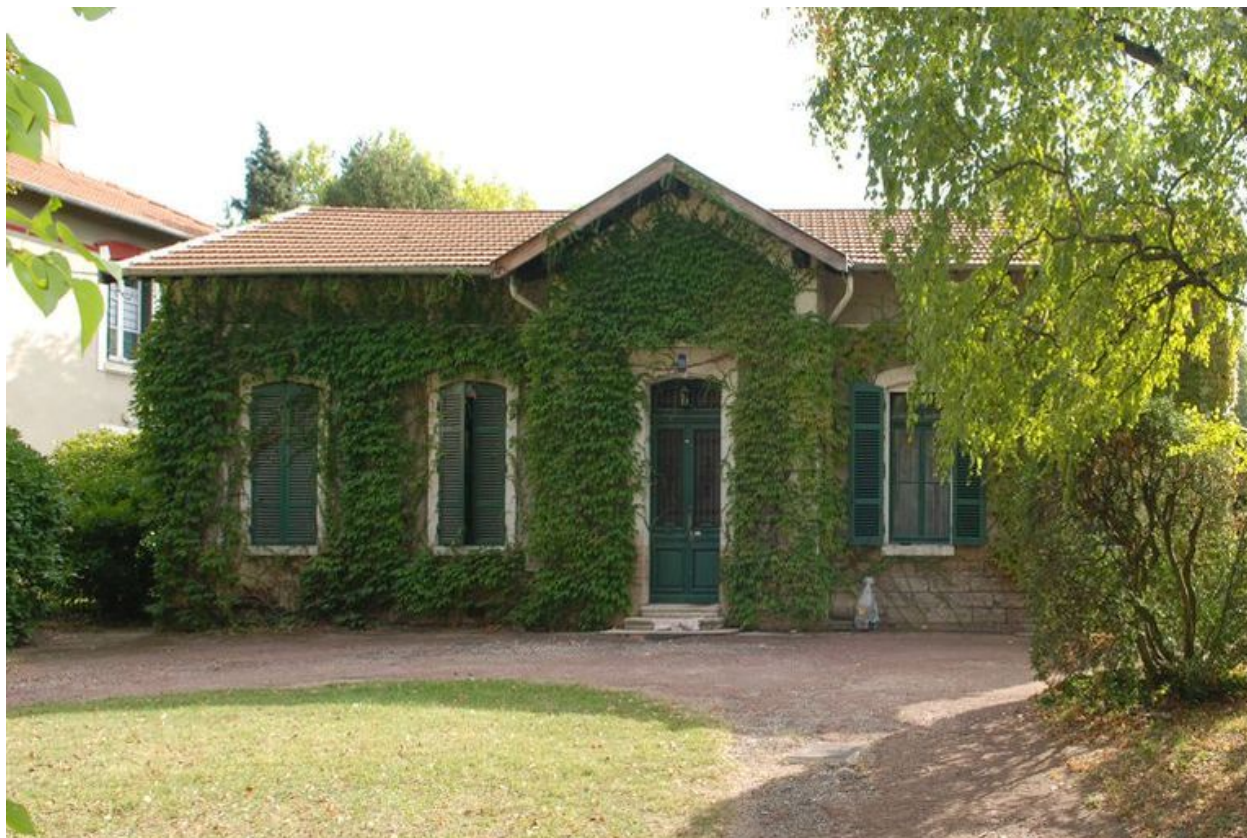
Bâtiment 223, façade principale (nord)
