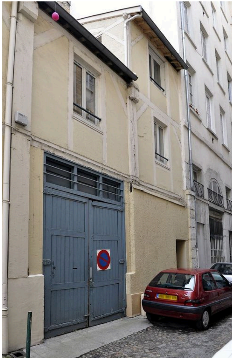
Façade antérieure : extrémité sud.
