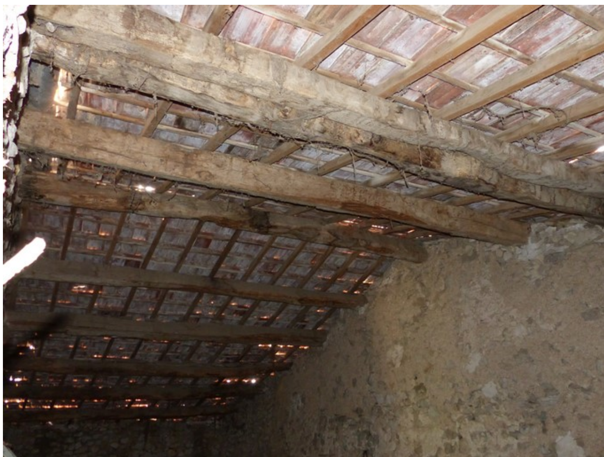
Charpente à pannes, ferme au quartier de Bigonnet.
