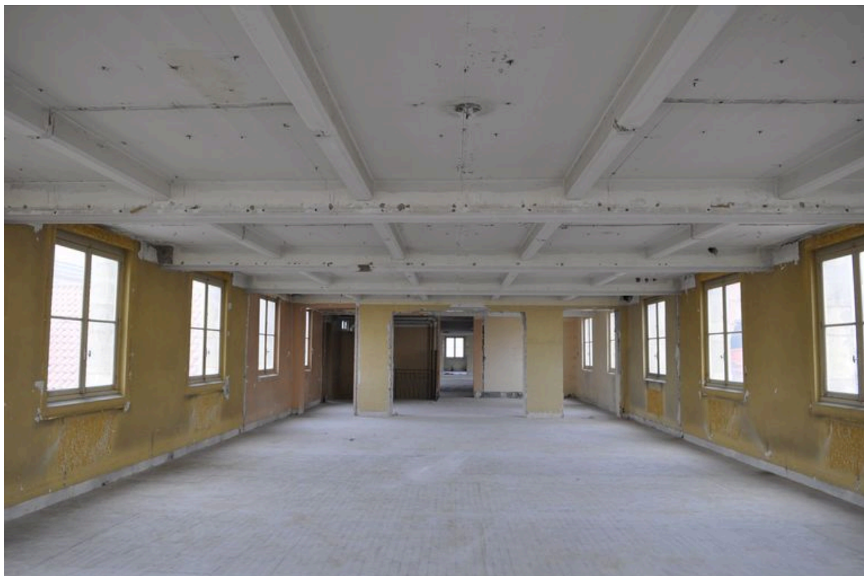
Vue du premier niveau de l'étage des dortoirs, entresolé en 1932.
