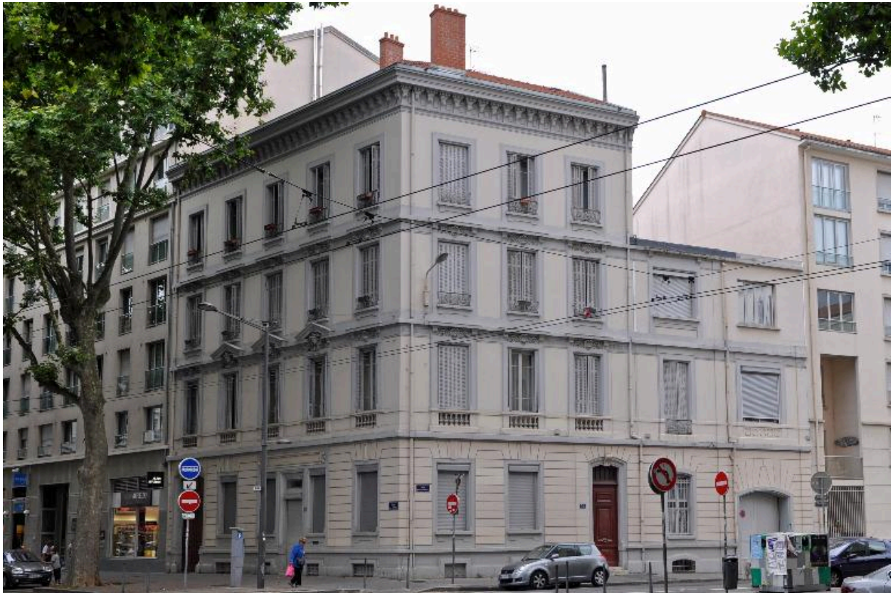
Vue d'ensemble, prise depuis le nord-ouest
