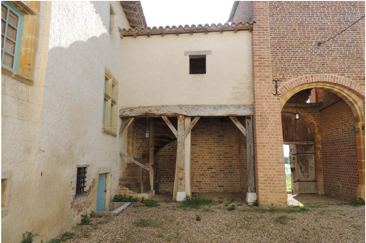
Élévation est, escalier d'accès au logis et galerie couverte.
