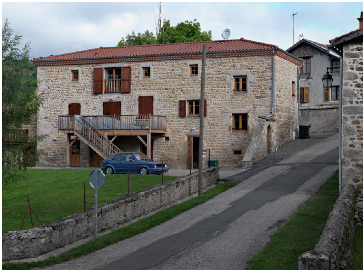
Vue générale depuis le sud-est (état en 2012).
