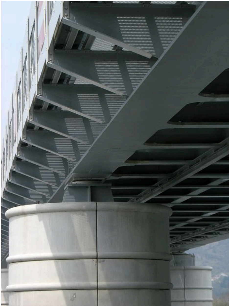
Vue partielle : dessous du tablier et pile
