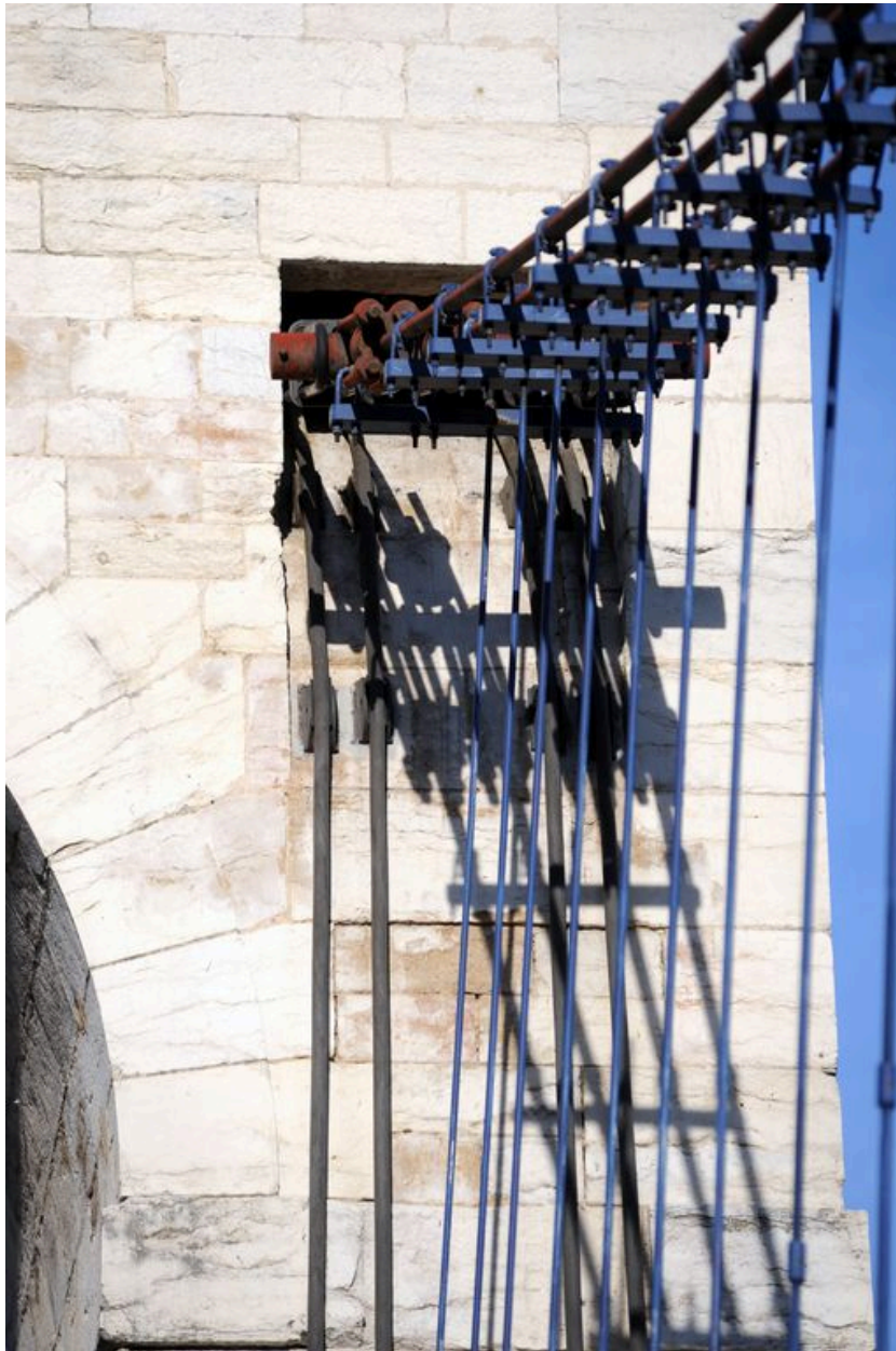
Pile centrale, vue de détail : ancrage d'un des câbles porteurs et jonction avec les suspentes (depuis la rive gauche)
