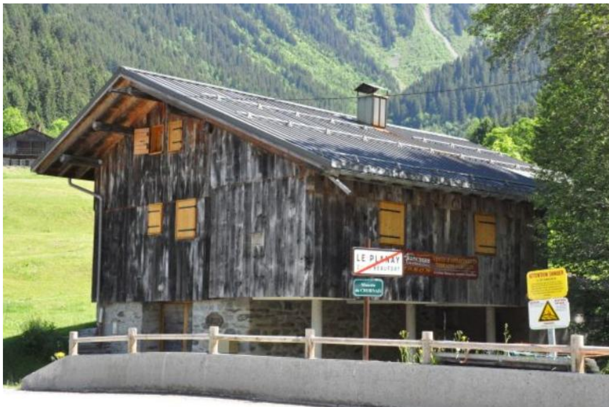
Pignon nord de la scierie.
