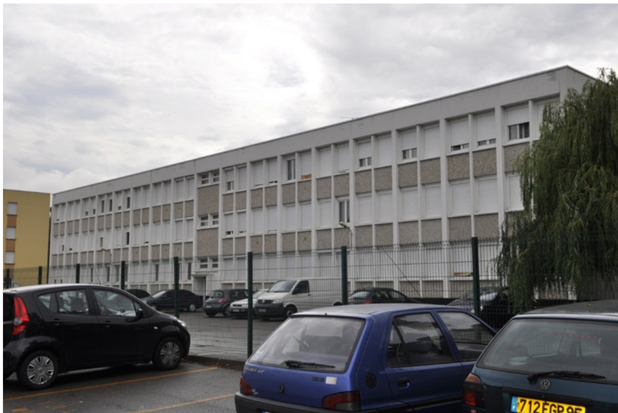
Bâtiment administratif datant des années 50.
