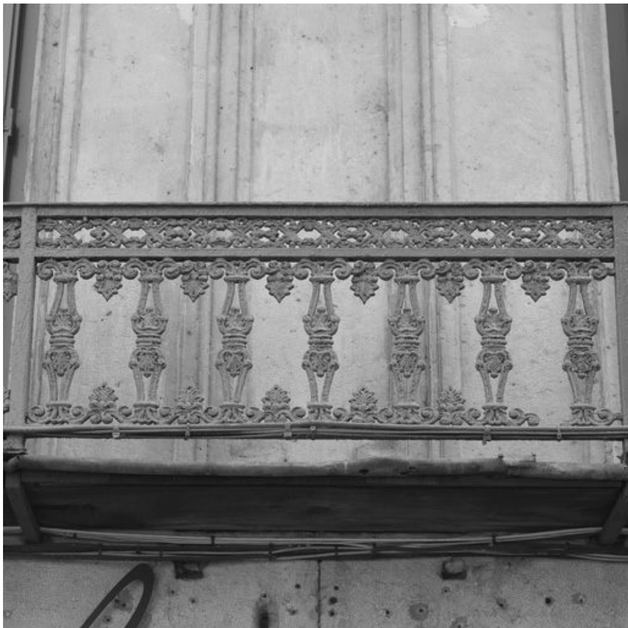
Elévation sur le quai Saint-Antoine : entresol, détail du garde-corps ornant le balcon filant
