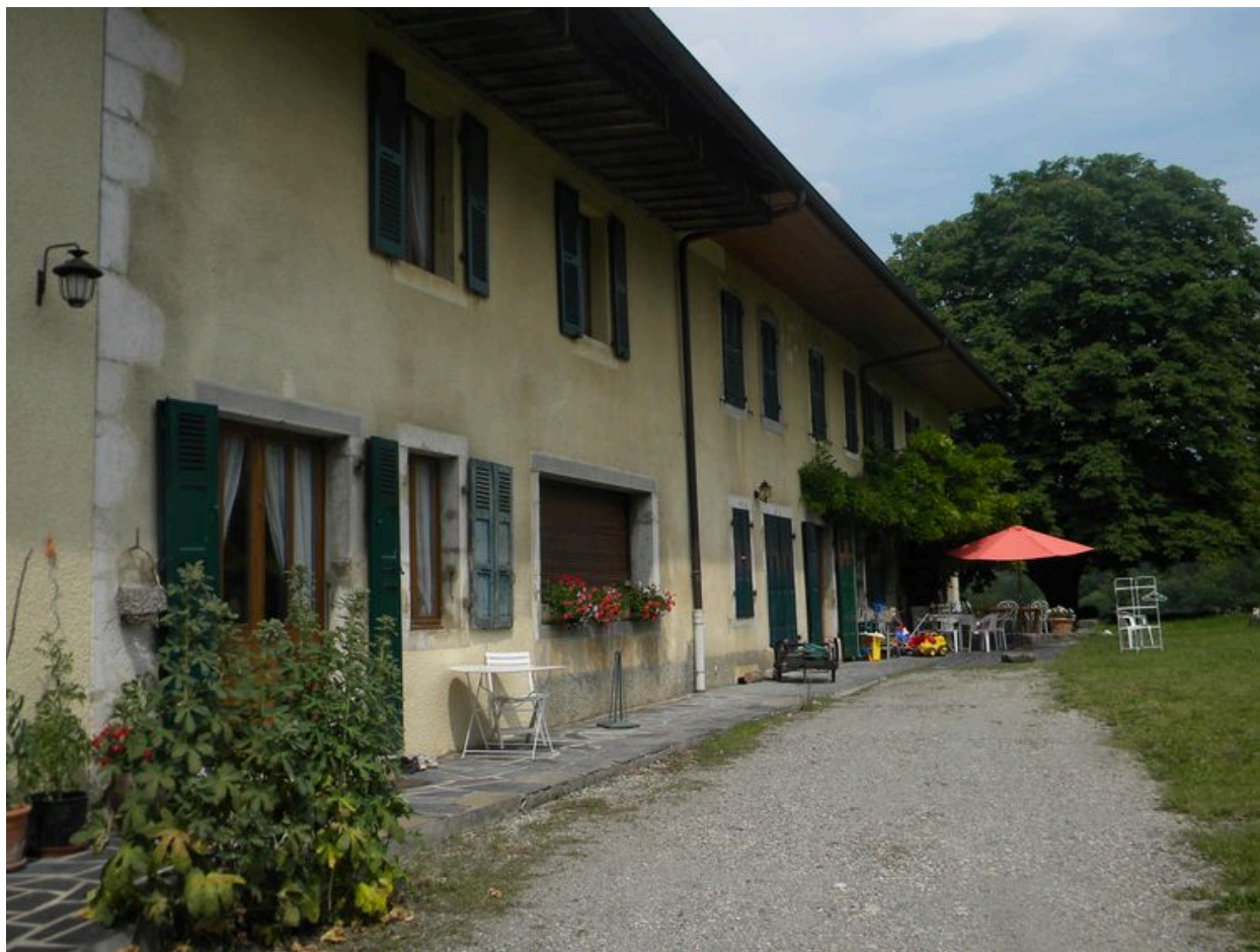
Alignement sur la façade principale
