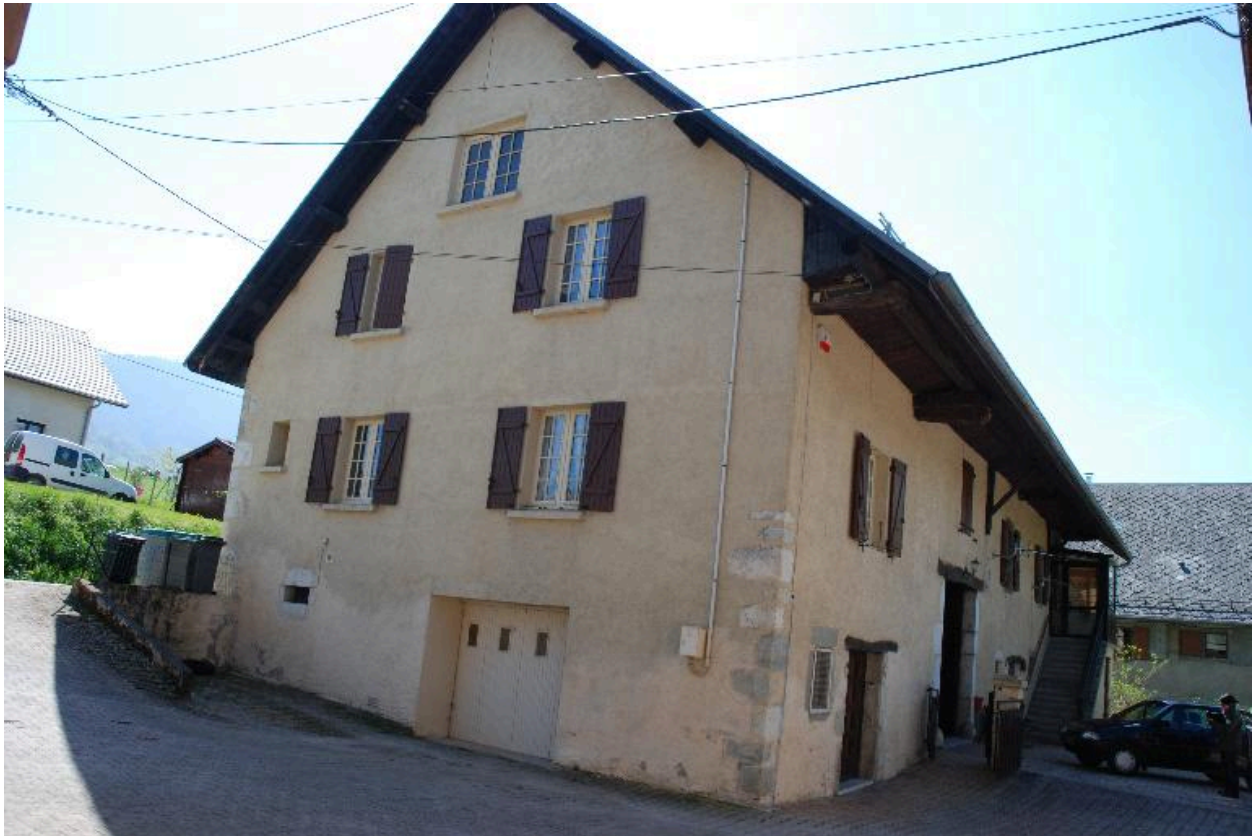
Les Farniers. Ferme, parcelle 2013 E1 398, vue d'ensemble de trois-quart avant gauche.
