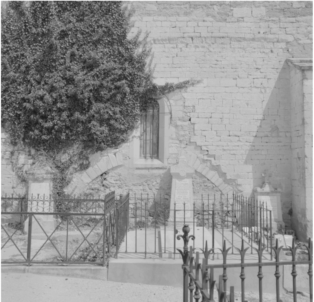
Elévation sud, détail : vestige d'enfeu et traces de reprise de construction.
