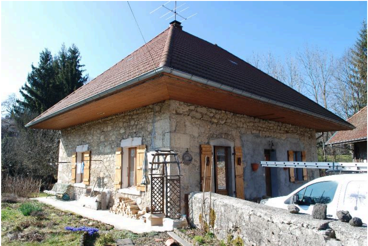
Vue d'ensemble de trois-quarts avant gauche du bâtiment d'habitation.
