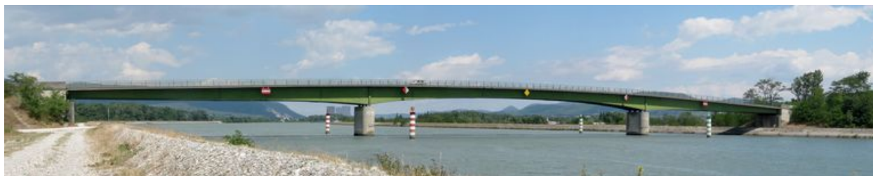
Vue panoramique, face aval (depuis la rive droite)
