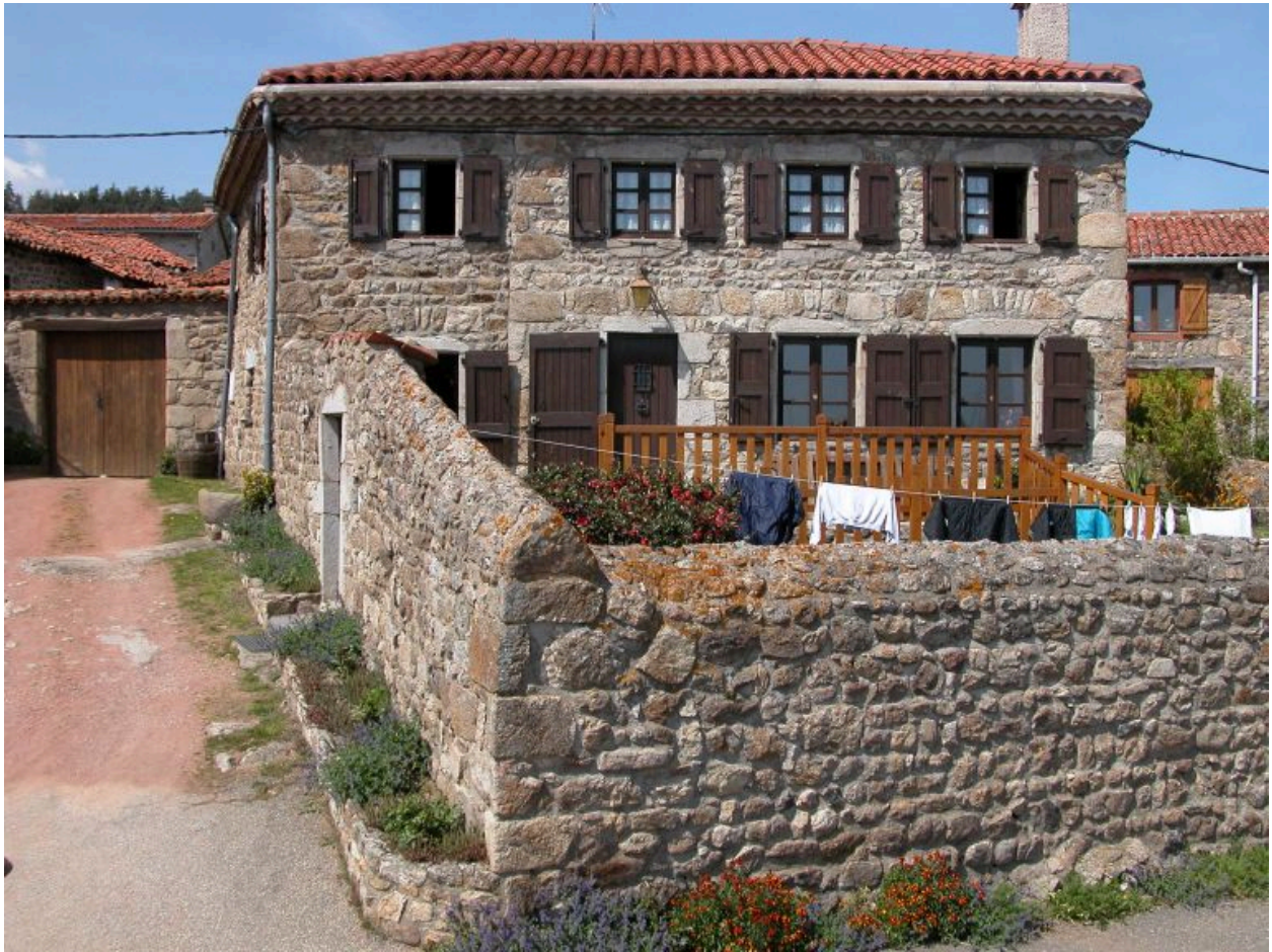
Vue générale de la ferme.
