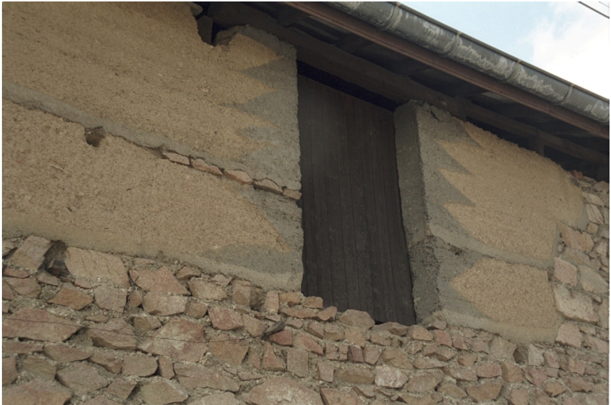
Boën, Petits-Prés, cuvage (1986 AI 137). Encadrement de baie en ciment (20e siècle).
