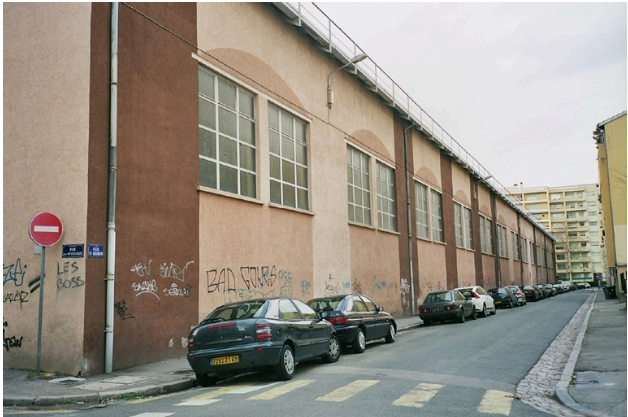
Façade rue Saint-Agan, vue sud
