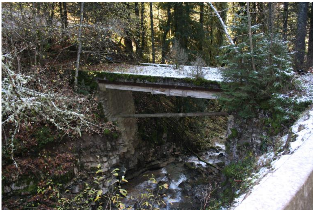
Vieux pont des Landoz, face amont
