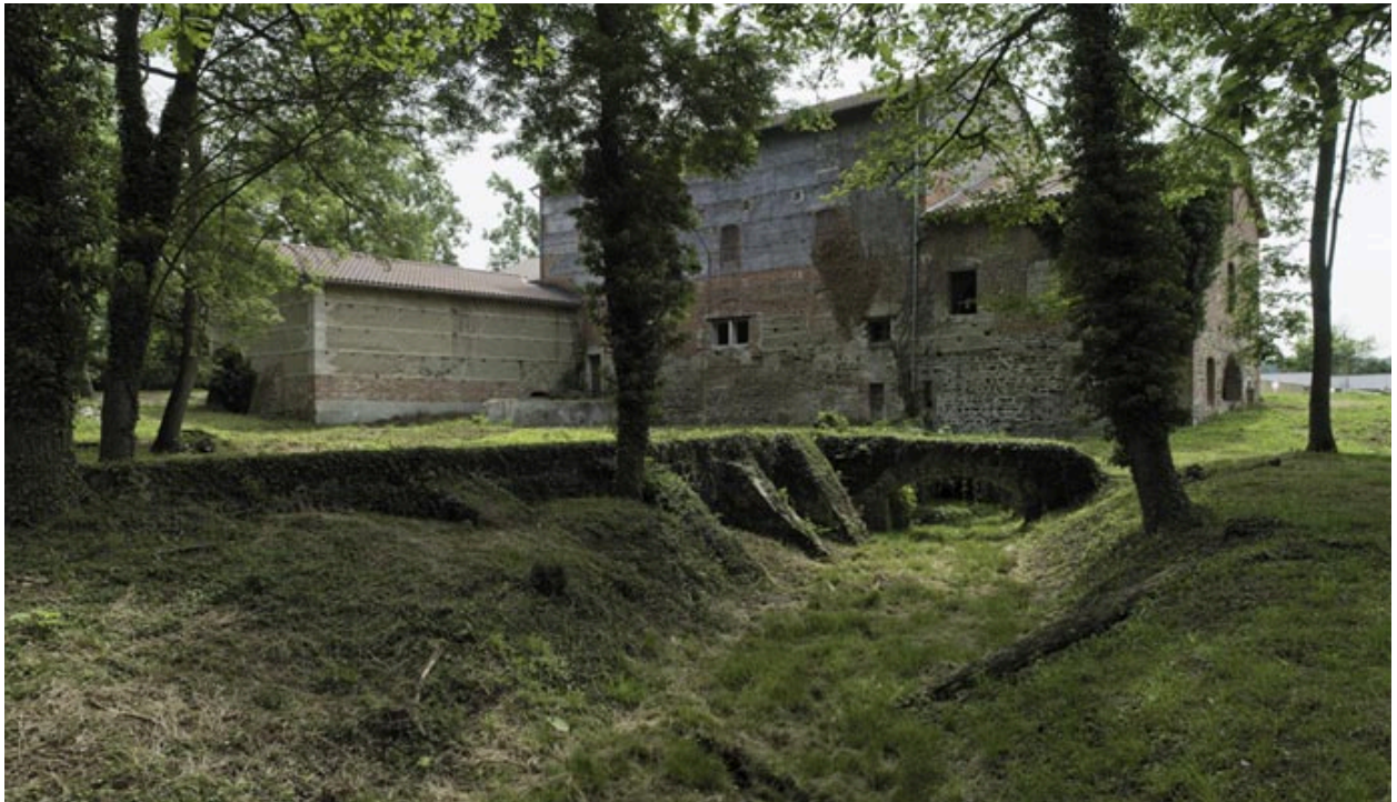
Vue du moulin et de l'étable, depuis le nord-ouest.
