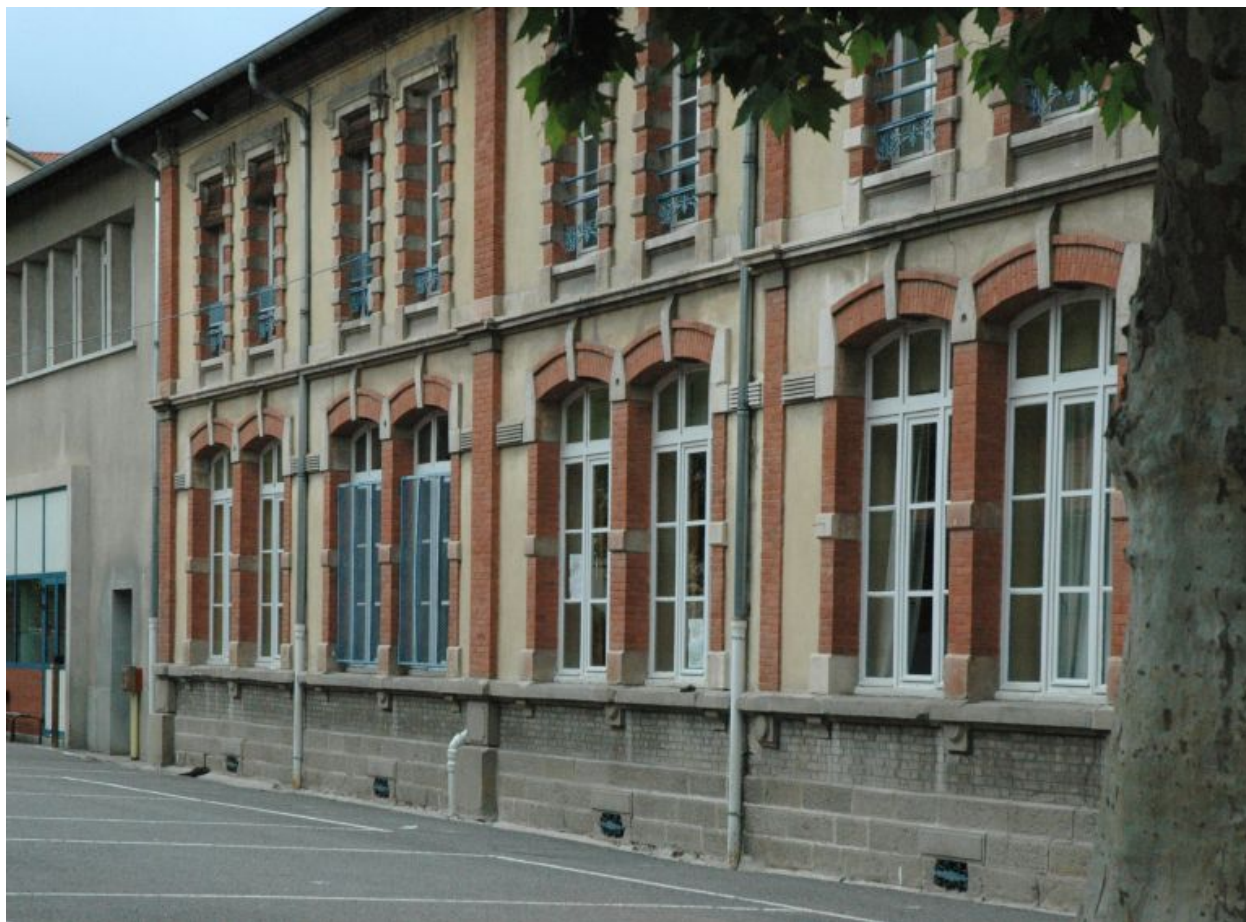
Vue partielle de l'élévation sur cour.
