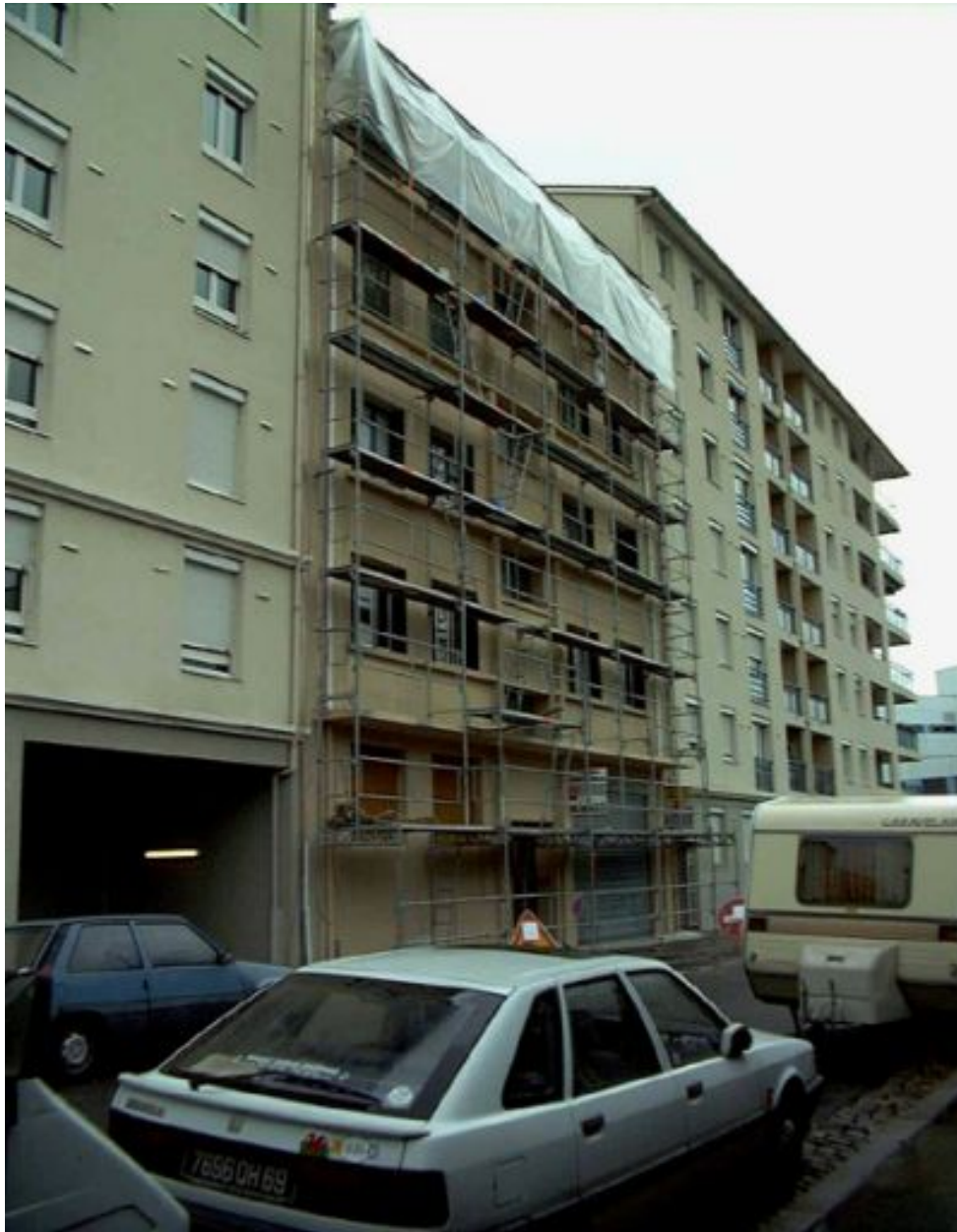
Vue générale pendant les travaux de réfection
