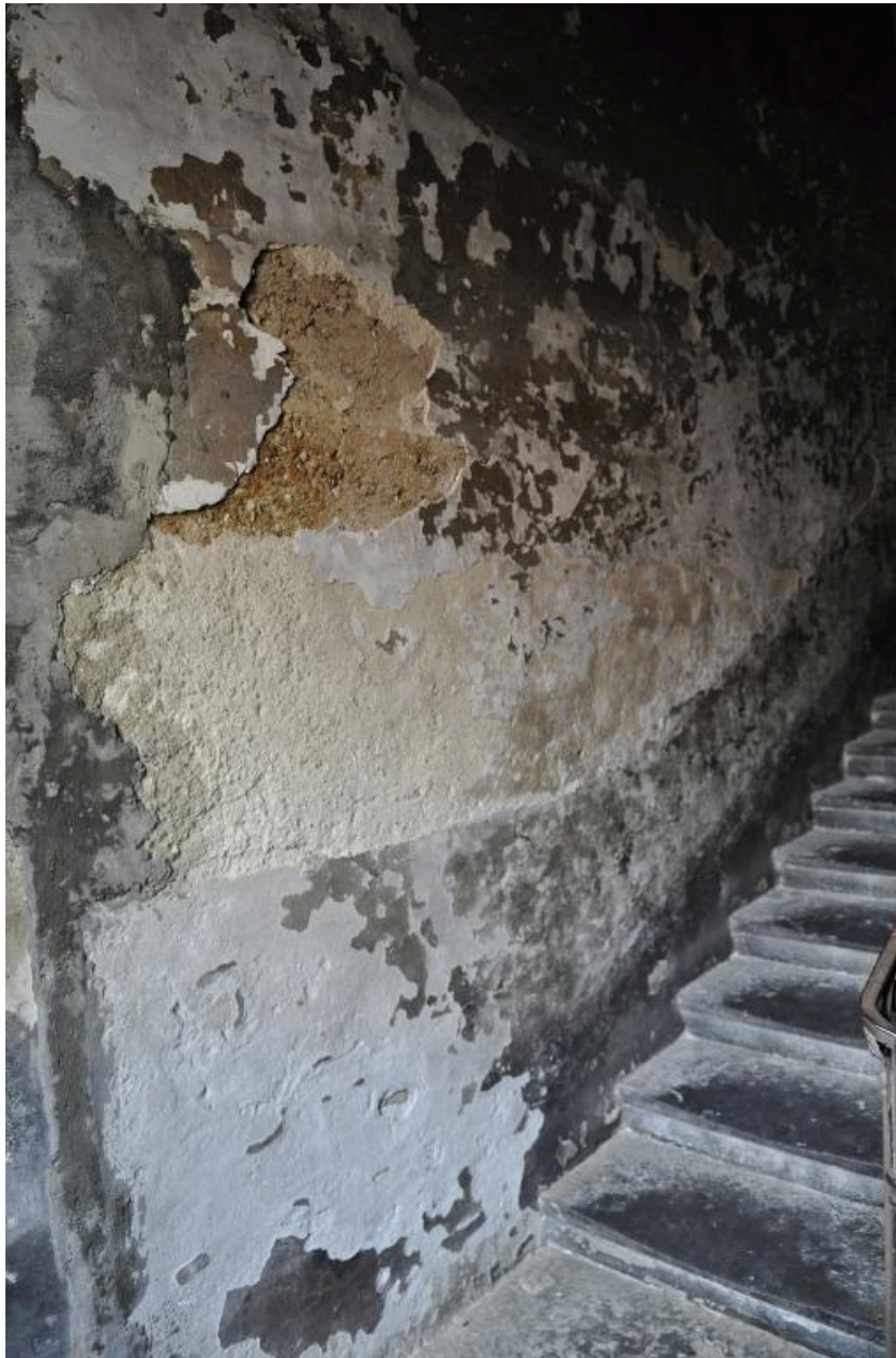
Vue du mur de la cage d'escalier
