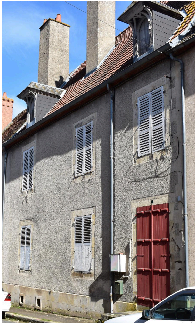
Vue de la façade, rue d'Allier.
