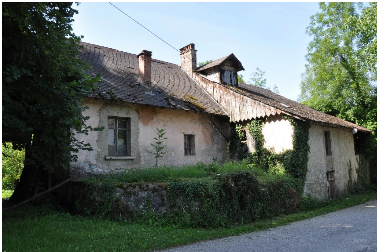
Vue générale de l'ancien moulin Berthollet, vue nord-est
