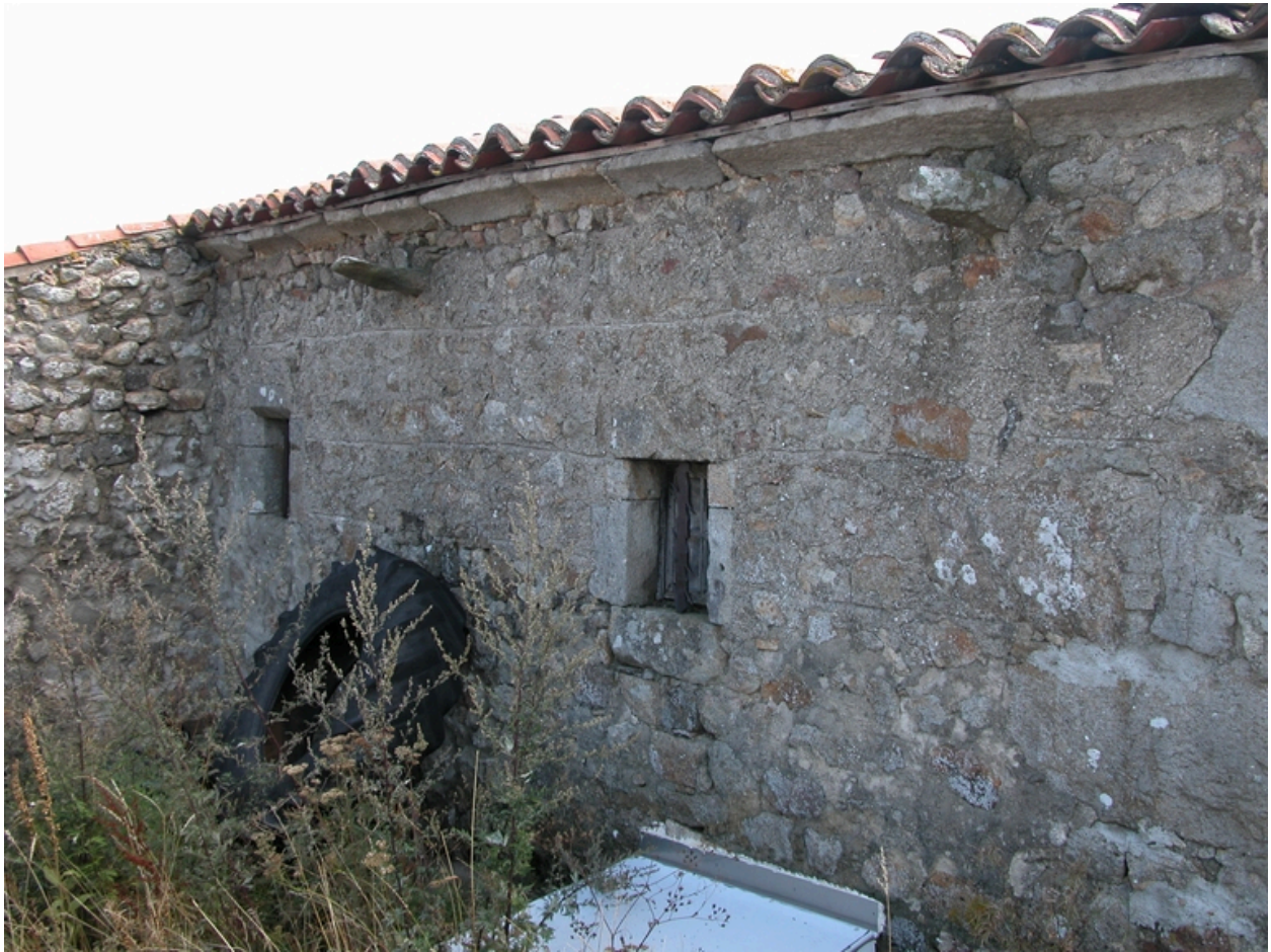
Vue de l'élévation arrière du logis.
