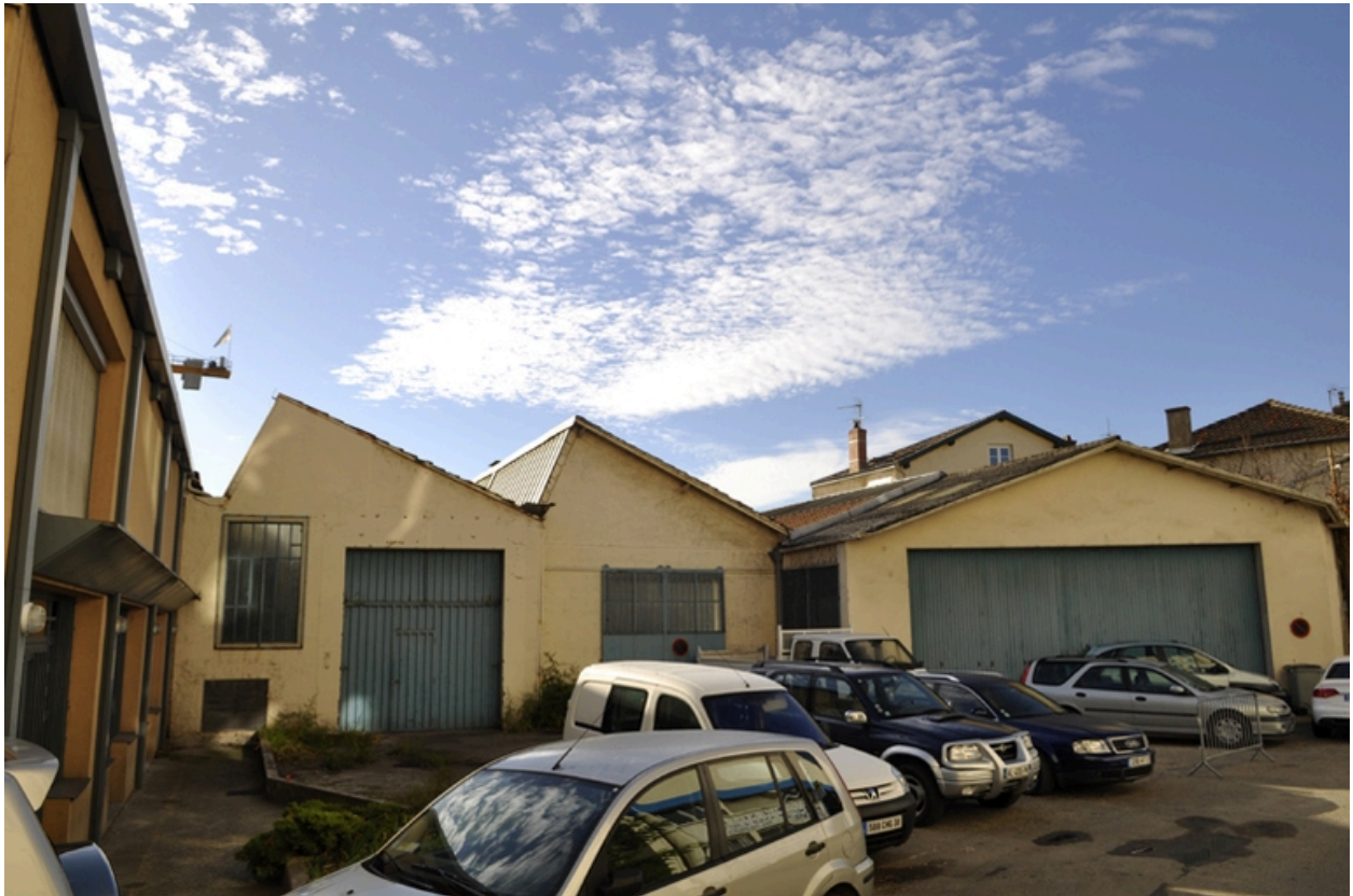
Vue d'ensemble est
