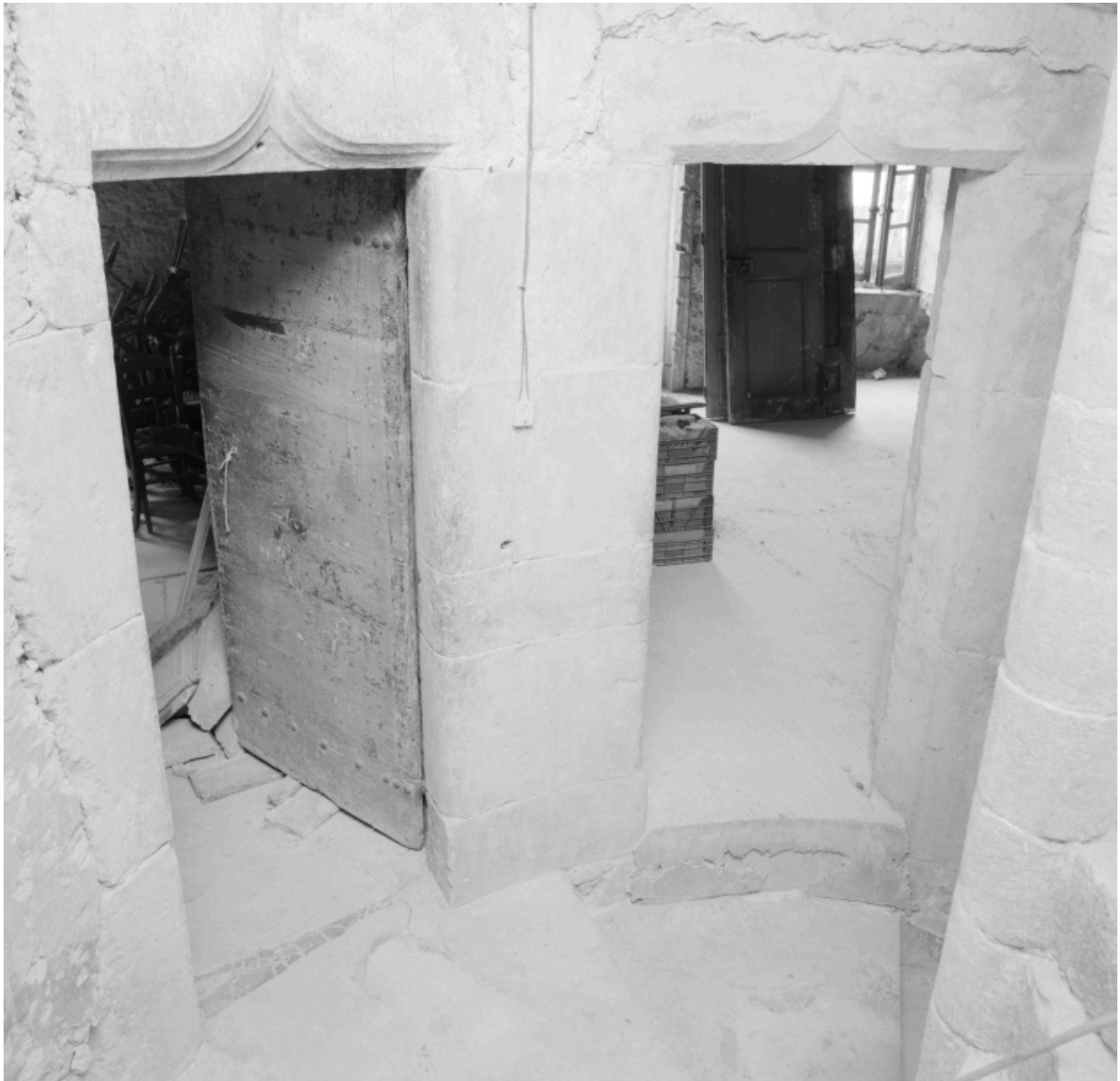
Escalier en vis, 1er étage, portes à linteau en accolade et piédroit commun.
